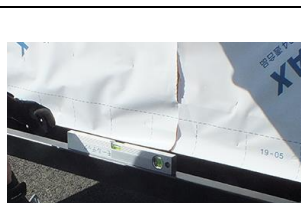
④水平器でフレームが水平か確認する
